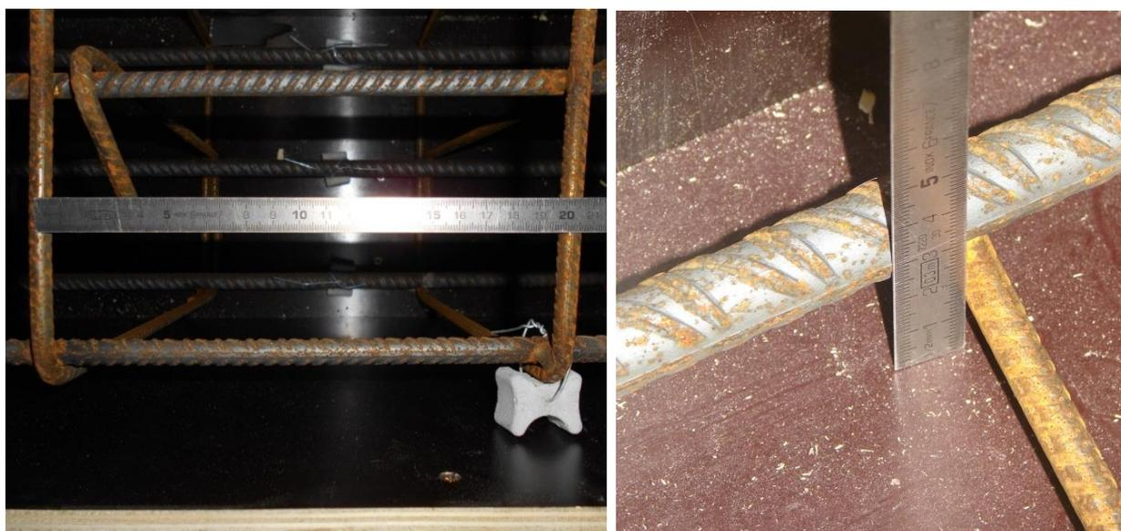
**Détails du ferrailage de la poutre**
