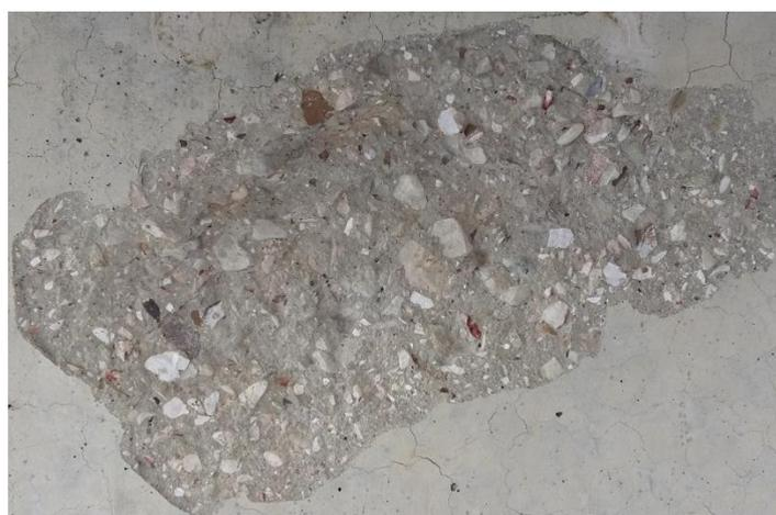
**Détails de l'écaillage de la poutre**
