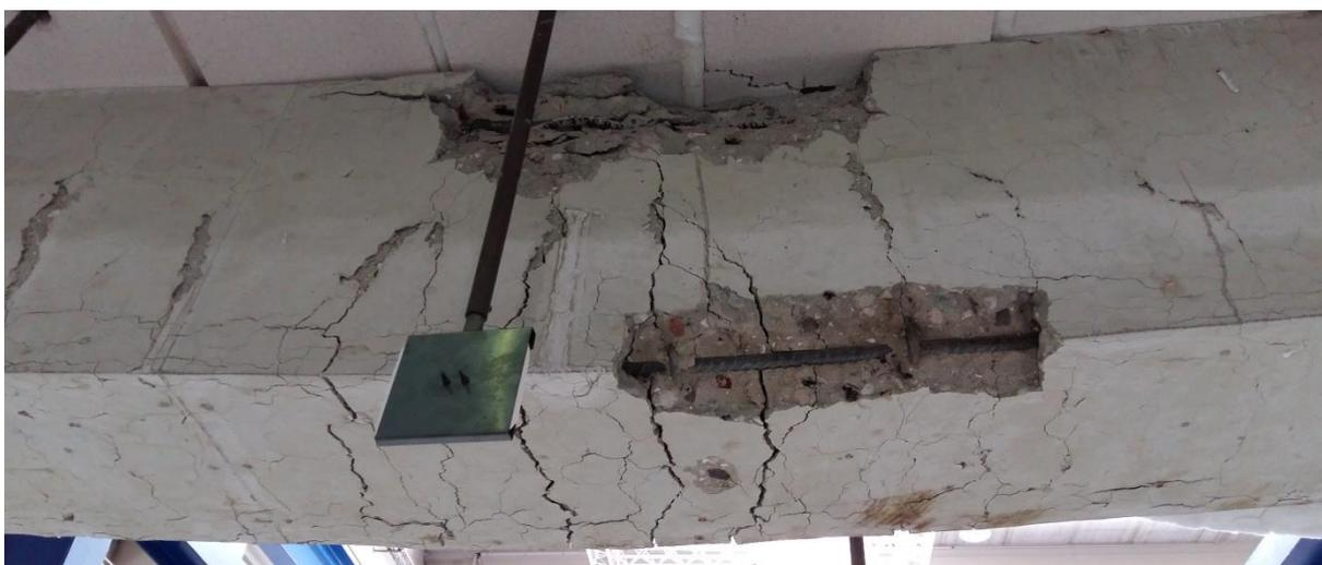
**Détail de la rupture de la poutre**
