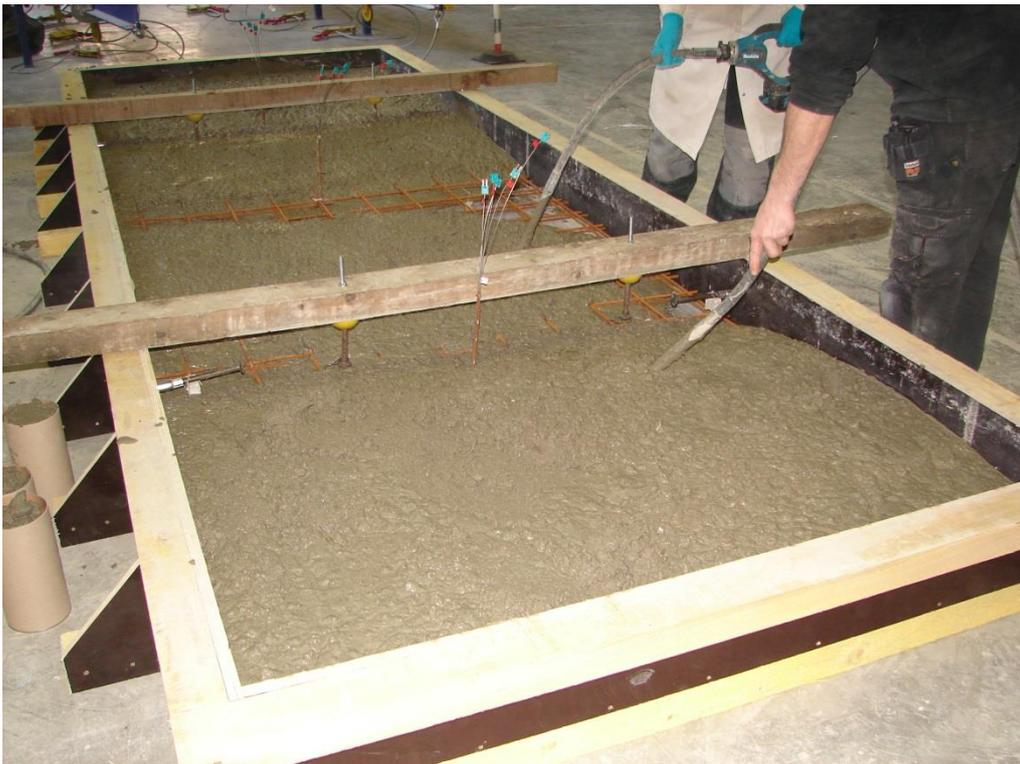
**Mise en place du béton à l'aiguille vibrante**
