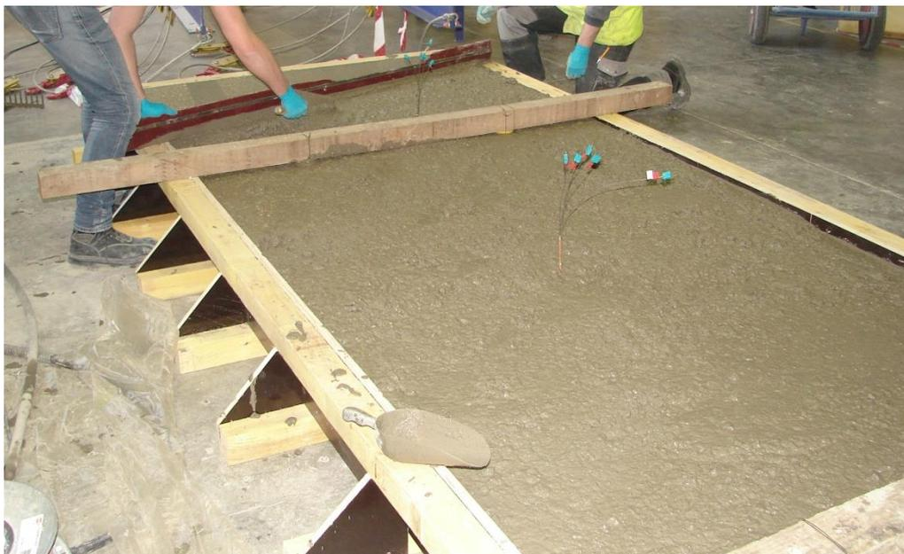
**Béton tiré à l'aide d'une règle de maçon**
