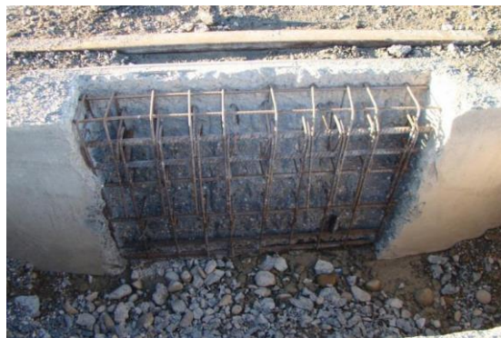
Figure 14- Résultat obtenu par hydrodémolition
