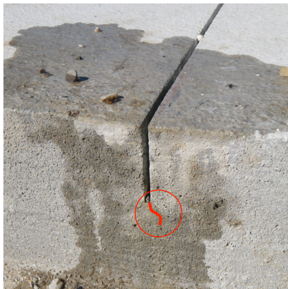
Figure 4 : Fissuration observée au niveau des joints de sciage sur les dalles
