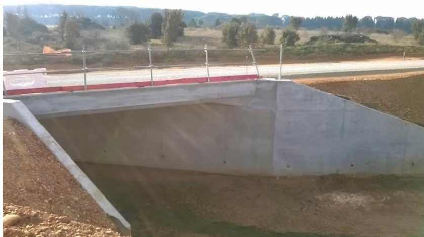
Figure 19. Photos du chantier expérimental du pont véloroute (CNM – crédit photo Bouygues TP)
