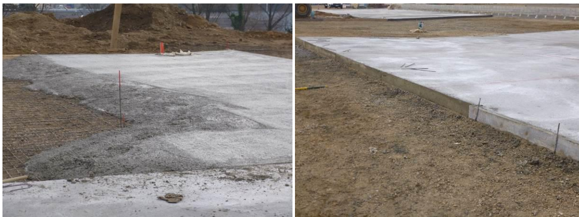
Figure 18. Photos du chantier expérimental du Chaponost
