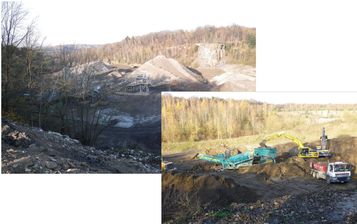
Vues d'ensemble de la plateforme Recynam
