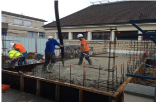
Coulage du béton recyclé
