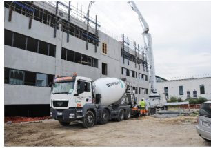
Bétonnage à la pompe
