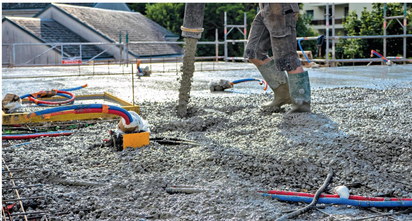
Sur le chantier Onze à Chartres, coulage d'une dalle d'étage en béton comprenant 20 % de granulats issus du recyclage, les Granudem de Poullard.
