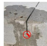
Fissuration observée expérimentalement au niveau des joints de dalle
